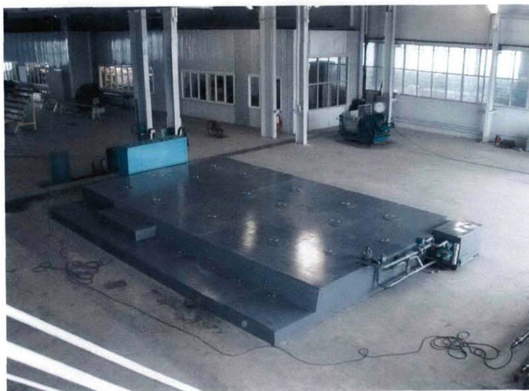
Рис. 28. Общий вид метрологической площадки после окончания строительства
