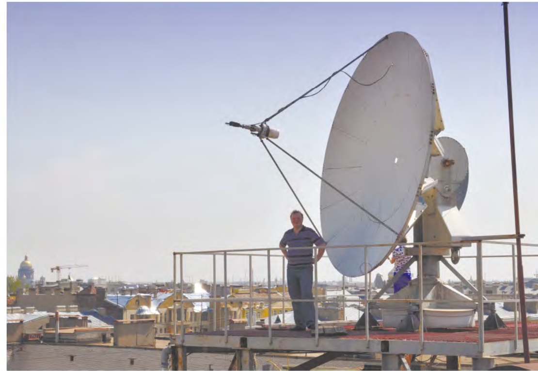
Антенный пост «Polus-3,8Н», используемый ВСЕГЕИ для получения данных со спутников Meteor-3М и NOAA 12–18
