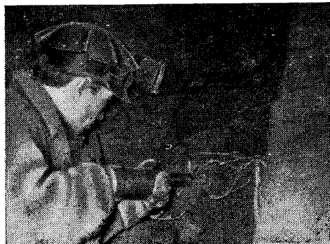
Рис. 7. Способ частичной разгрузки ручной дрелью с алмазной коронкой
