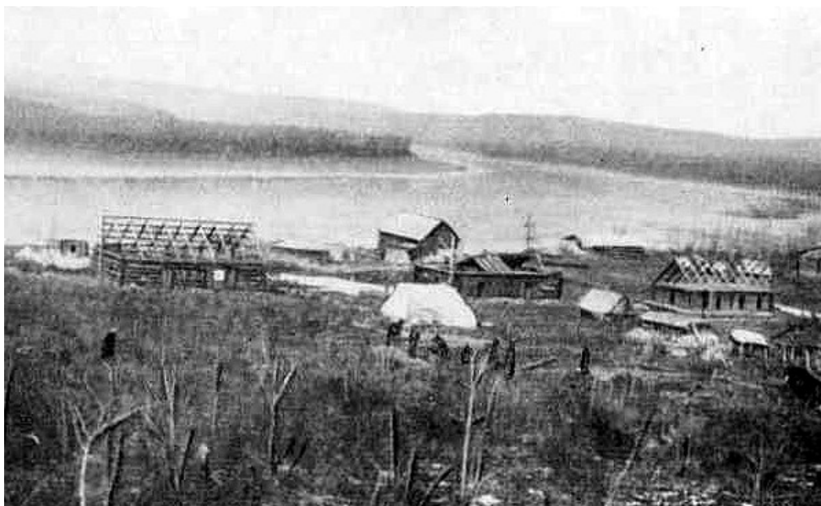
Приютившийся на правом берегу Колымы поселок Усть-Среднекан в 1931 году выглядел довольно убого.
