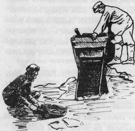
Рис. 16. Ваггерт (справа) и корейский лоток (слева).
