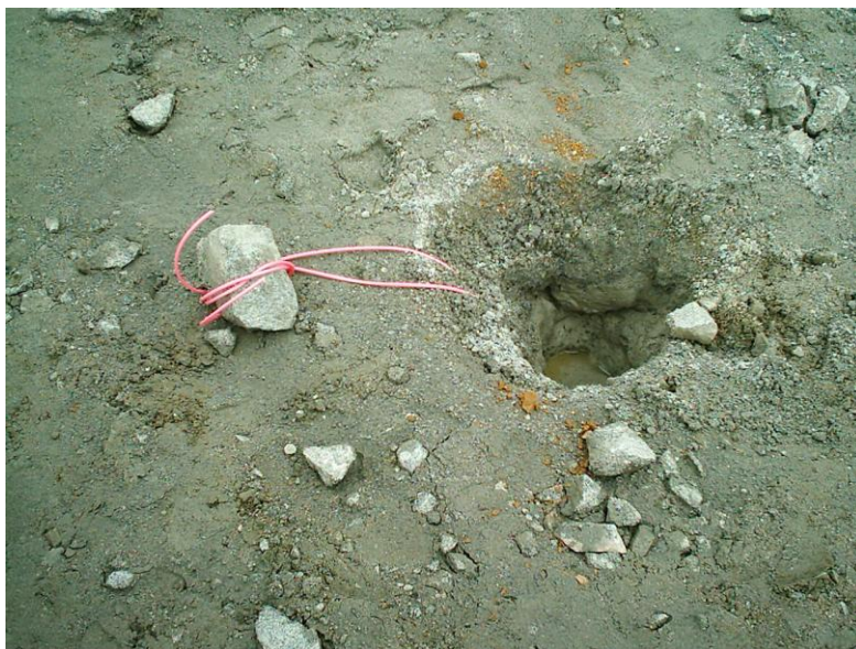
Рис. 2.9. Забойка скважины столбом вытесненной воды
