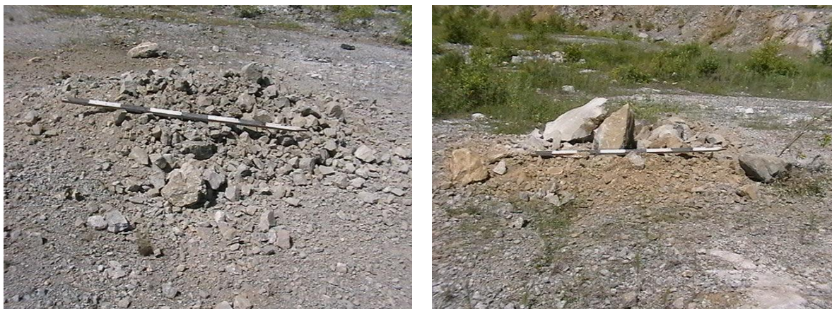
Рис.3.12. Воронки выброса после взрыва скважин с бетонными забойками
