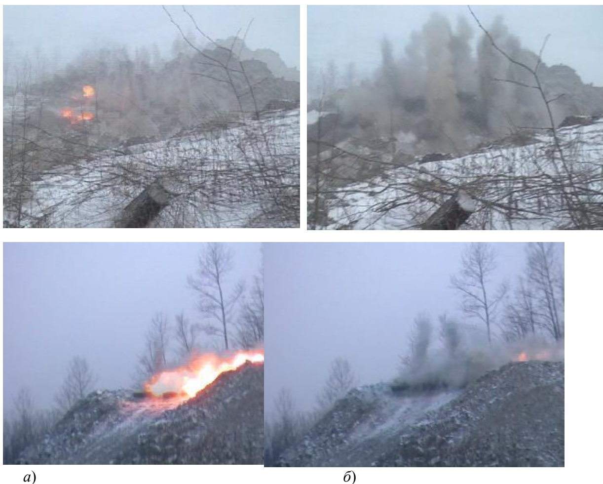
Рис. 2.5. Проникновение продуктов детонации через засыпную забойку
