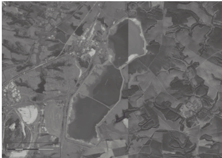
Рис. 2—Гидроотвалы Михайловского ГОКа
