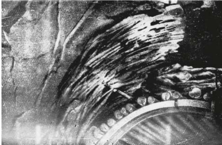
Рис. 1.1. Вторичная складчатость (расслоение, вызванное напряжениями) пород кровли вблизи крепи [Айзаксон, 1961]
