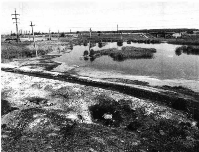
Рис. 1.5. Общий вид (сверху) насыпного отвала клинкеров Беловского цинкового завода, дренажной канавы и болота-отстойника.
