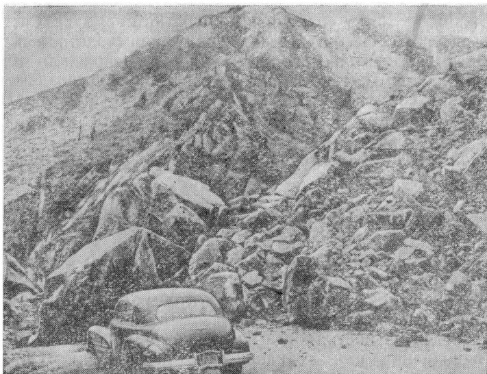
Рис. 1.5. Неустойчивость склонов. Мощный оползень, возникший при прокладке шоссе в штате Колорадо в 1957 г. (по данным Барнеби).
