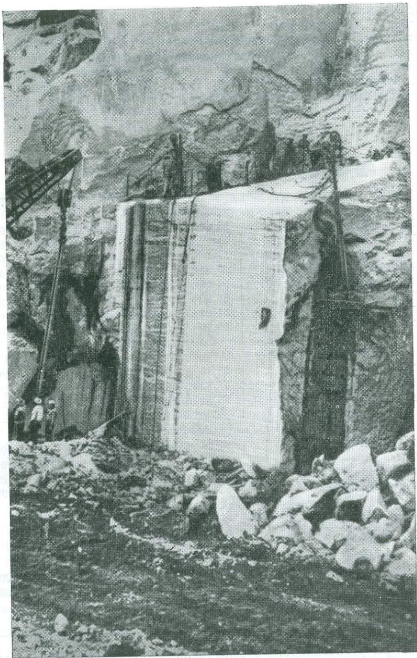
Фиг. 3. Выемка гигантского моноблока мраморов разновидности Грис Сибоней в карьере Сьерра де-Лас Касас на о-ве Пинос
