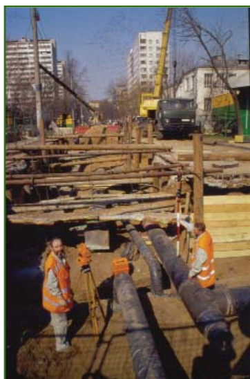
Рис. 1 Исполнительная съемка подземных коммуникаций
