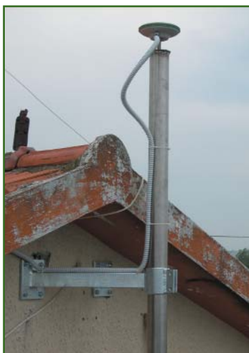
Рис. 3 Крепление антенны спутникового приемника на стальной трубе
