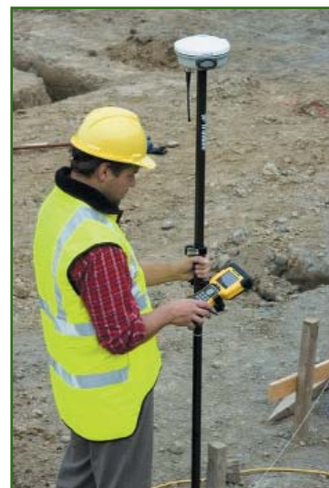
Рис. 1 Вынос проекта в натуру в режиме RTK
