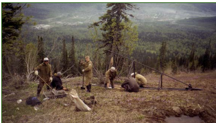
Рис. 2 Установка пункта полигонометрии
