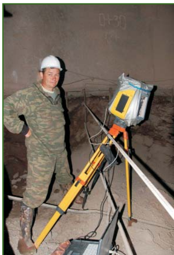
Рис. 5 Съемка сканером подземного сооружения
