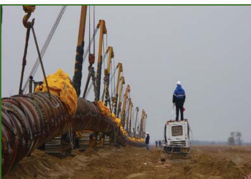
Рис. 6 Укладка трубы
