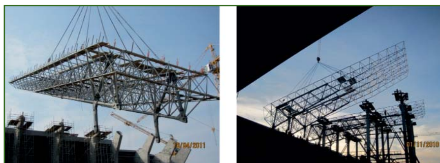
Рис. 5 Монтаж секций навеса
