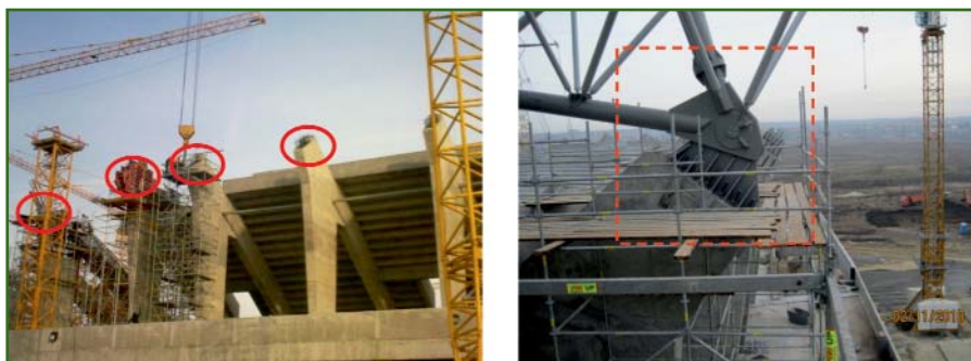
Рис. 4 Места установки и расположение опорных деталей навеса
