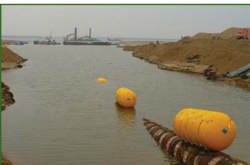
Рис. 7 Балластировка подводного перехода
