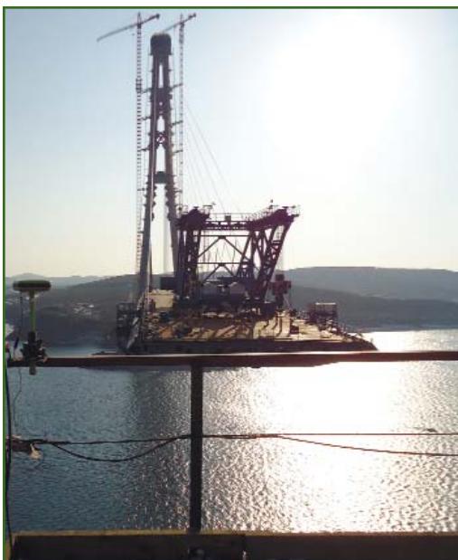
Рис. 4 Применение приемников ГНСС JAVAD при монтаже панелей
