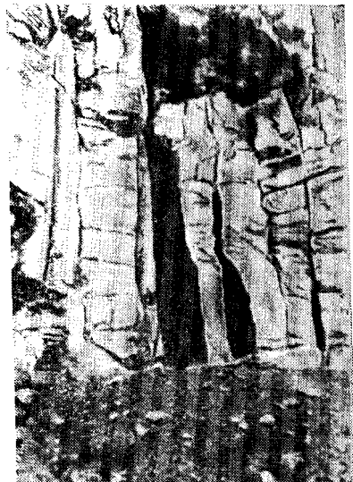
Рис. 73. Трещины первичной отдельности, расширенные выветриванием (фото Н. И. Кригера)
