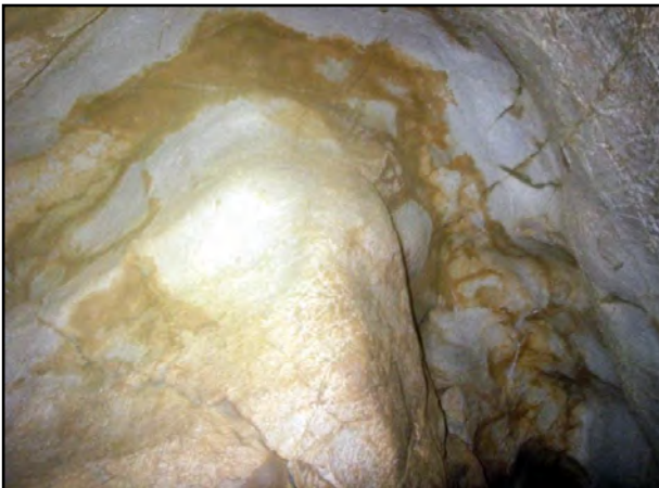
Рис. 6.8. Пещера Большая Махнёвская. Трещины в кровле галереи на её изгибе
