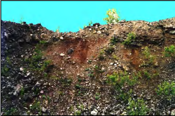
Рис. 4.9.155. Карьер № 5, т.н. 7063. Верхняя часть откоса карьера – трещиноватые известняки, средняя и нижняя – глинистый материал
