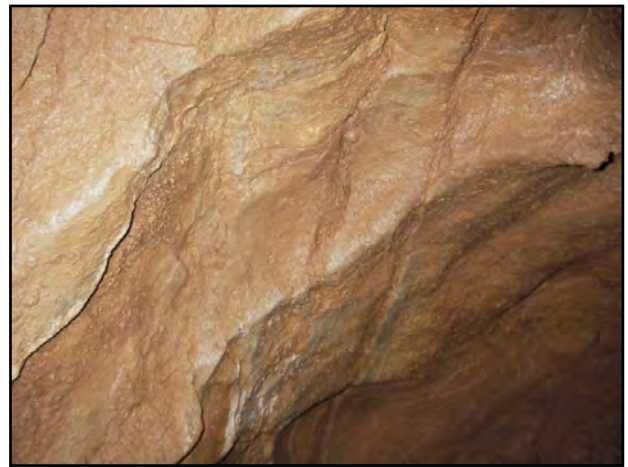
Рис. 6.9. Пещера Усьвинская; неглубокие трещины в кровле Восточной галереи
