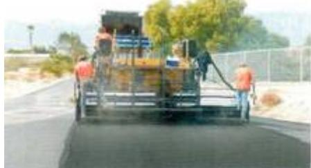
Полностью бесконтактные системы управления асфальтоукладчиками, разработанные компанией *TOPCON*, предназначены для выполнения асфальтирования с автоматическим контролем поперечного уклона, ровности и толщины покрытия с точностью  $\pm 1.5$  мм по высоте. При подготовке ровной поверхности, в качестве источника формировать лазерную плоскость на большие расстояния.
