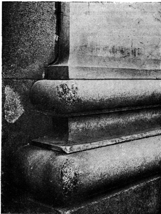
Фиг. 5. Базы одного из пилястров дворца с явлениями выкрашивания мрамора на углах выступов базы. Светлое пятно в левой части снимка представляет собою след отслоившейся от гранитной стены пластинки.
