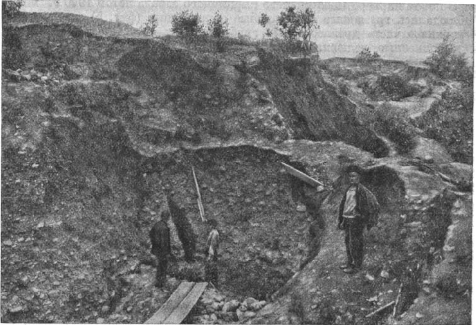
Фиг. 4. «Гравийный» карьер в отложениях II надпойменной террасы Волги у прист. Песочное. Вверху галечника видны крупные валуны
