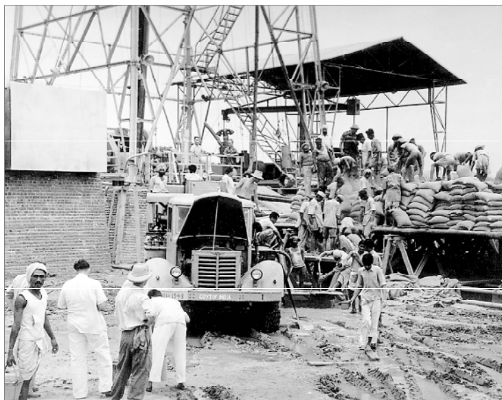
Напряженная работа на скважине — идет цементаж, 1960-е гг.
