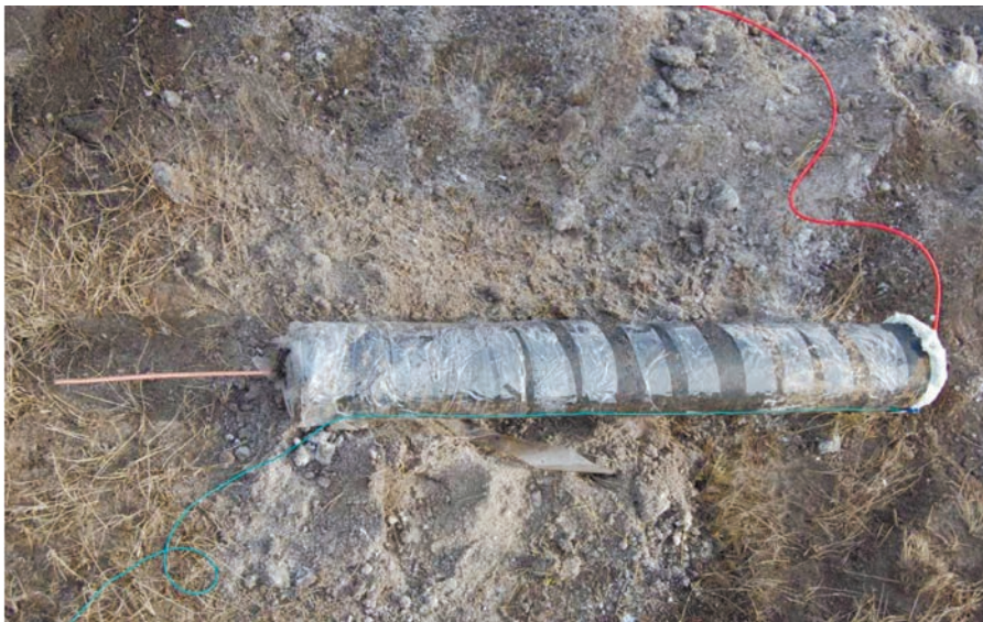
Рис. 3.10. Медная трубка в заряде ЭВВ. Показан момент вставки ее снизу заряда ЭВВ.
