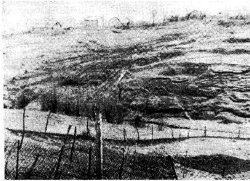
Рис. 84. Оползень-поток в г. Черновцы
