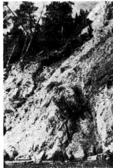
Рис. 85. Оползни-обвалы гипса. Камское водохранилище
