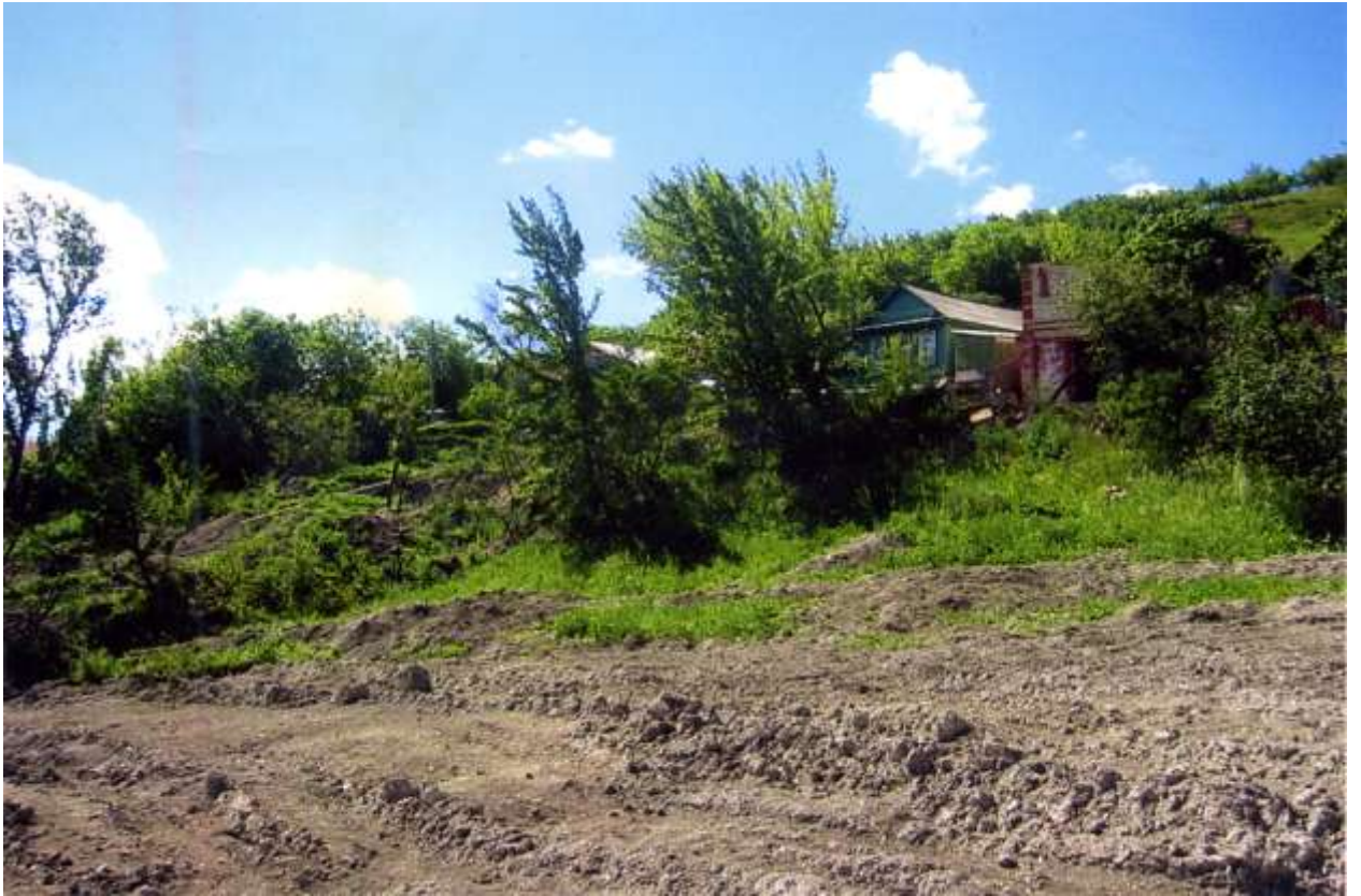
Рисунок 33 Разрушение сооружений в оползневой зоне (Смирновское ущелье)
