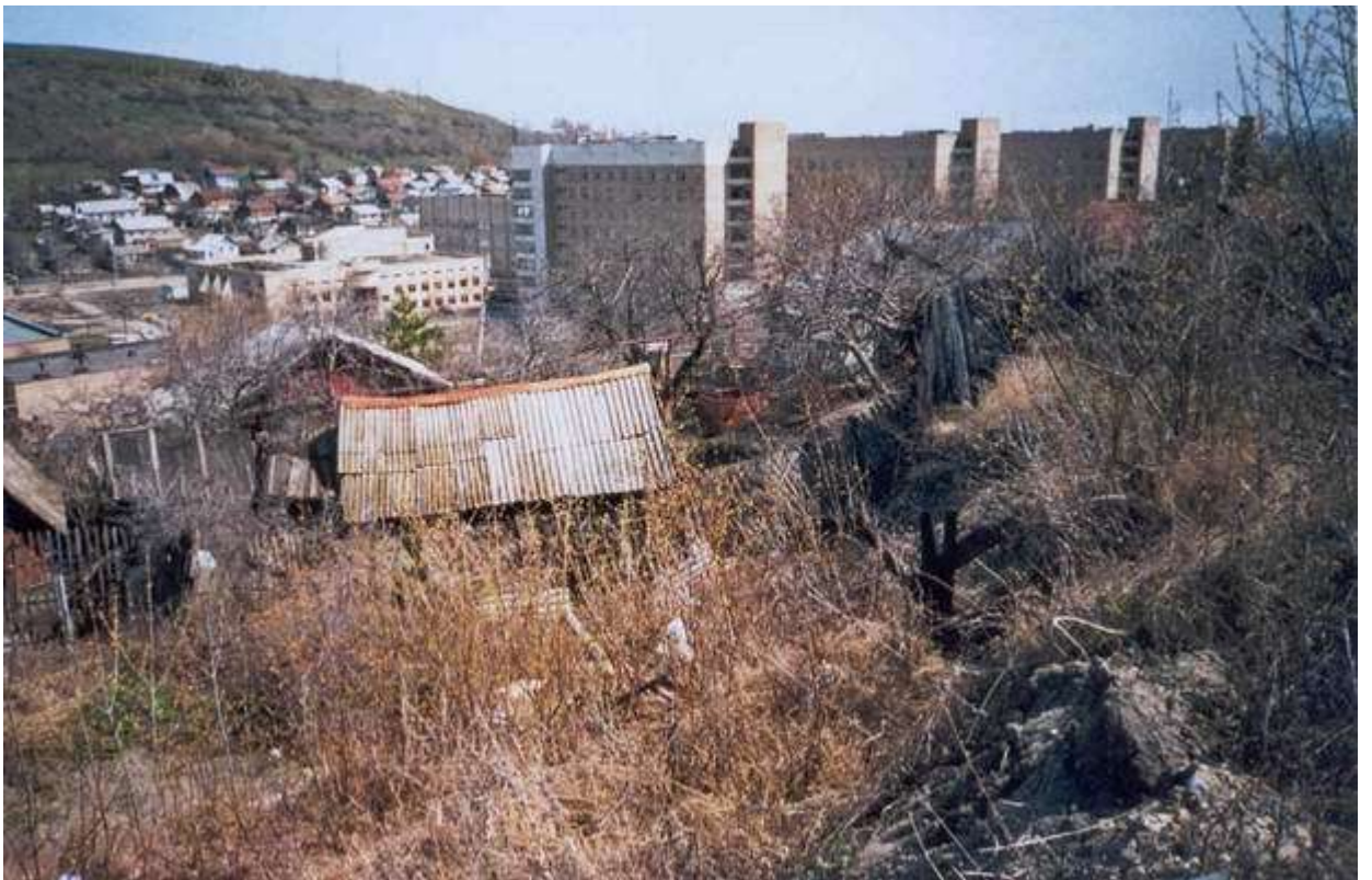
Рисунок 34 Трещина отрыва за домами №№ 81 и 83 (Смирновское ущелье)
