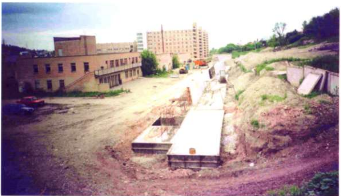
Фото 2 : Противооползневые защитные сооружения в Смирновском ущелье
