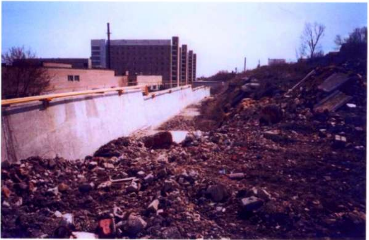
Фото 1 : Противооползневые защитные сооружения в Смирновском ущелье
