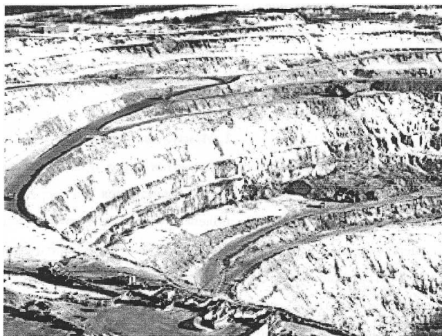
Рисунок 7.5 – Участок борта карьера рудника «Железный» ОАО «Ковдорский ГОК», сформированный с применением вертикальных откосов уступов высотой 24 м
