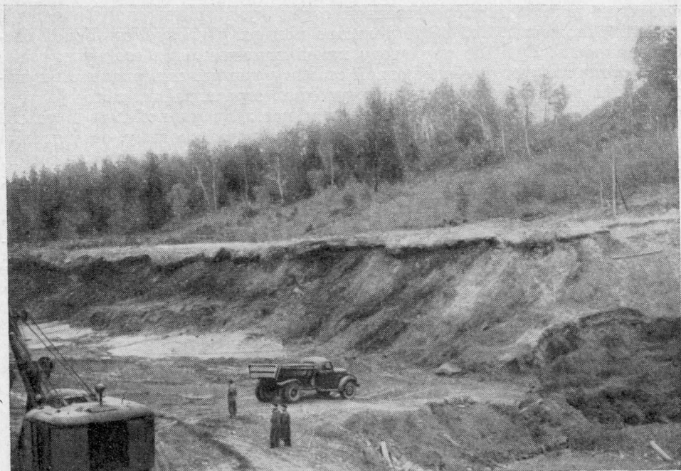
Рис. 55. Стенка котлована в «ледоносном» аллювии 6—8-метровой террасы на правом берегу р. Белой около с. Мальты
