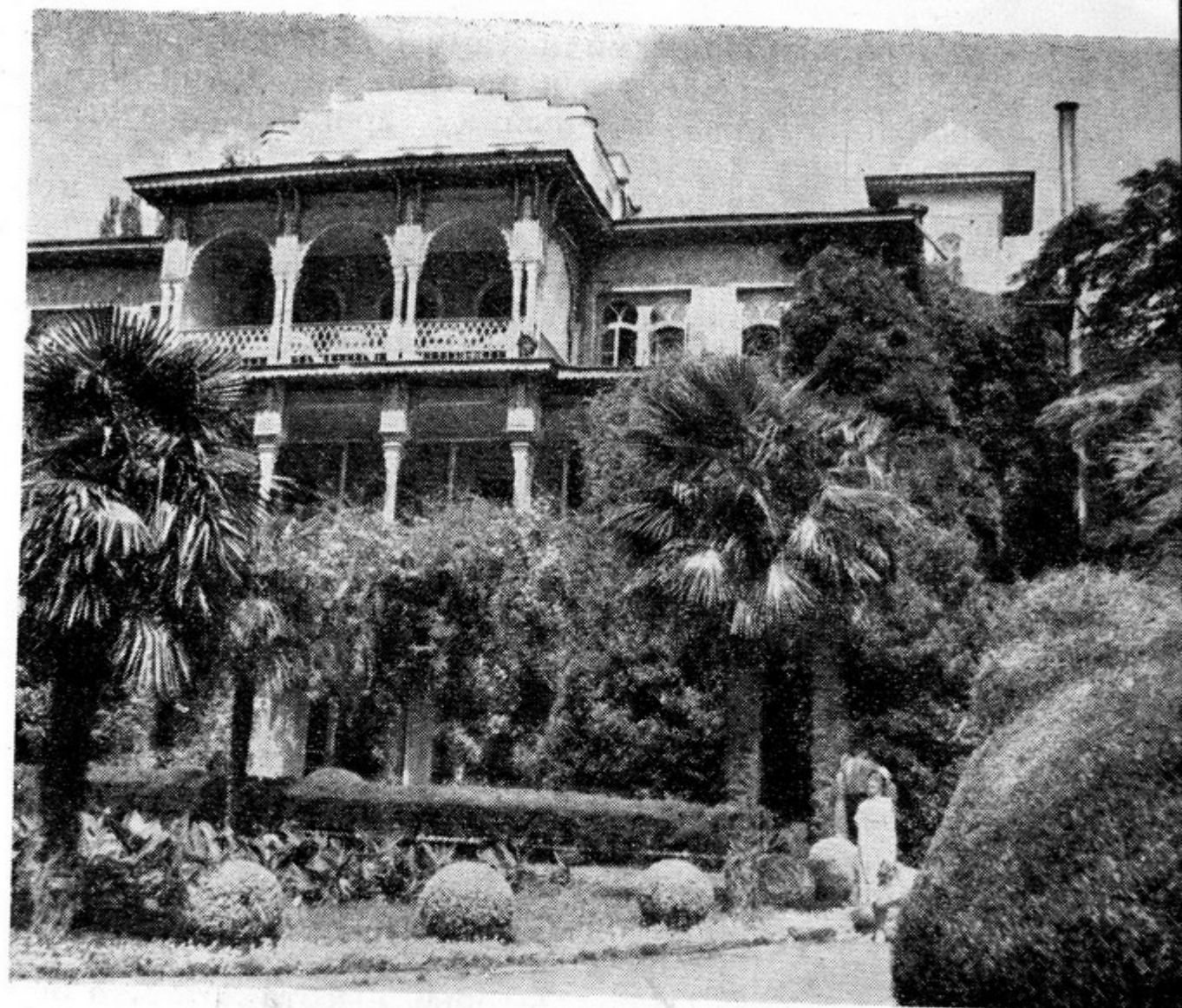
Главный корпус санатория «Карасан».
