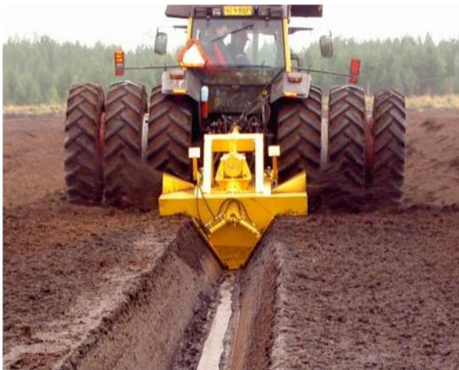
Рис. 2.16. Финский фрезерный каналокопатель Suokone для рытья канав на торфяных полях OJ-0.7 К, OJ-1.0 К и OJ-1.3 К
