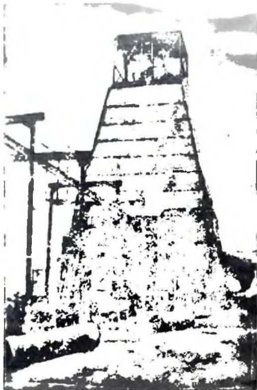
Рис. 63. Общий вид эстакады с тельфером из ствола шахты
