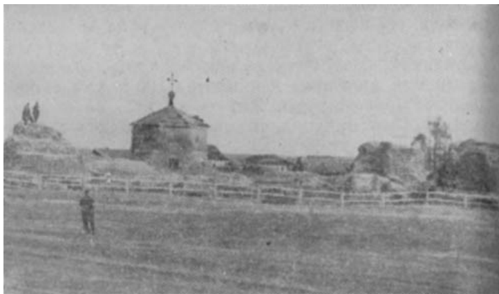
Рис. 32. Остатки городища древней столицы булгар ниже устья Камы. Стены зданий построены из камня, закрепленного очень крепким цементом
