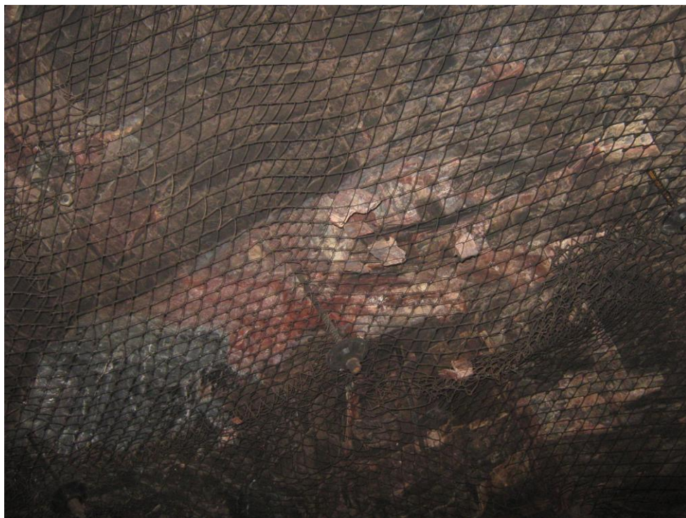
Рисунок 3.9 – Отслоение пород кровли выработки
