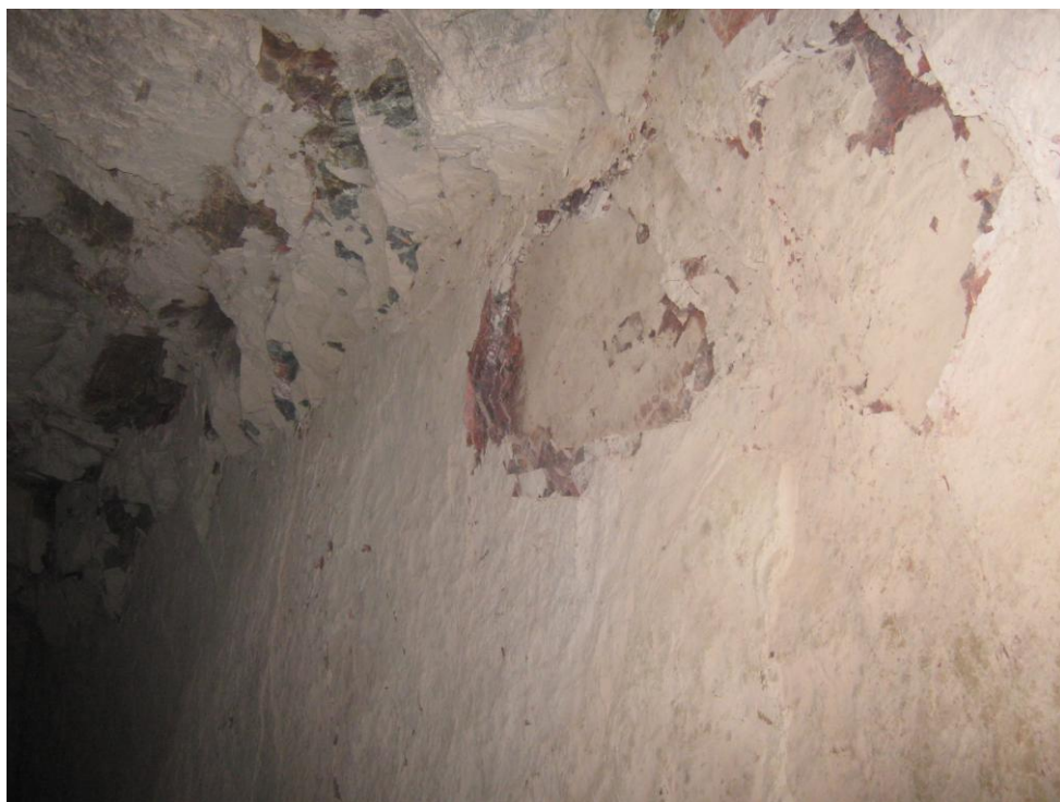
Рисунок 3.10 – Отслоение пород боков выработки
