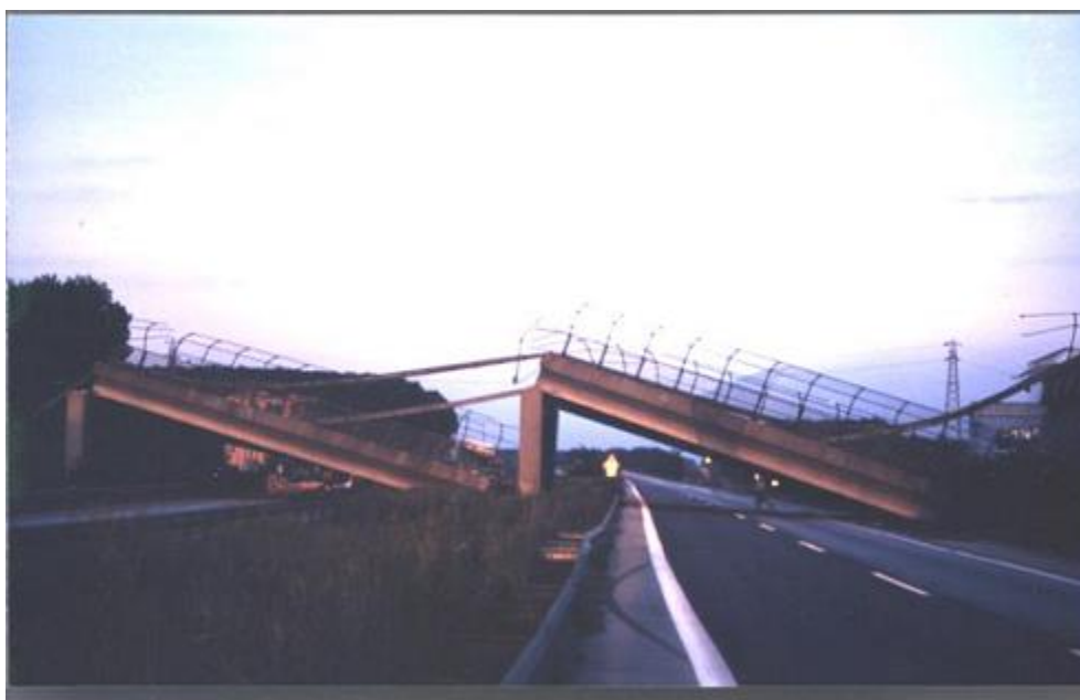
Рисунок 1.2 – Фотография сброшенных пролётных строений путепровода Arifiye (Турция)
