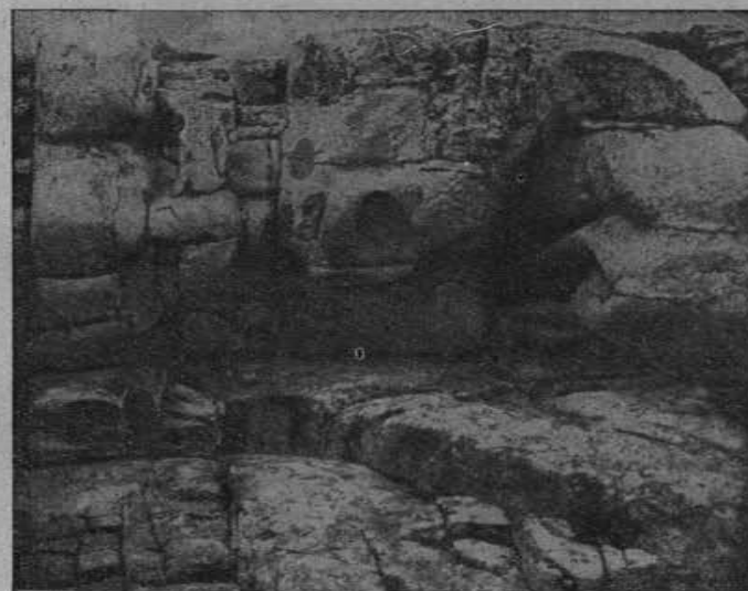
Рис. 244. Пластовые трещины в среднедевонских гранитах Центрального Казахстана
