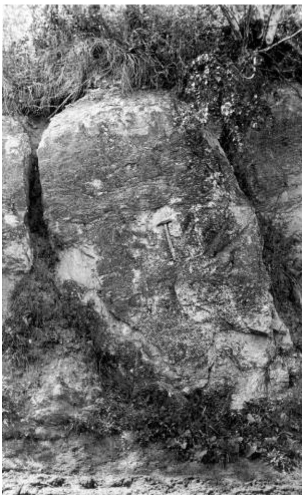
Рис. 5. Правый крутой и высокий борт долины р. Кан выше с. Петропавловка (Рыжево). Плотные кремнелые известняки ловатской свиты
