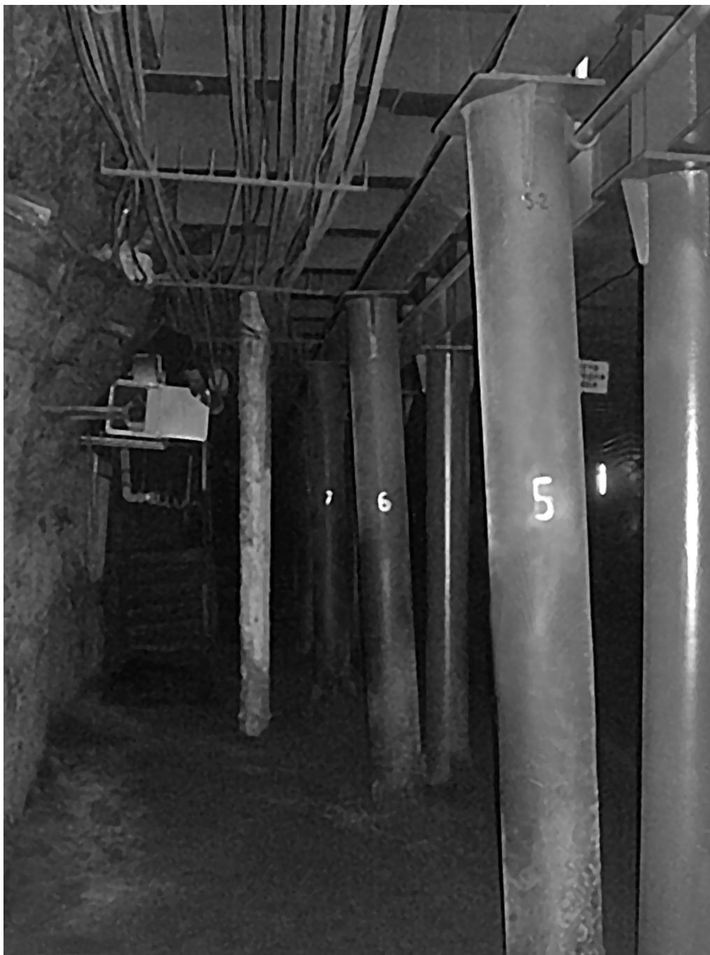
Рис. 2.4. Деформированные стойки рамной крепи в выработке шириной более 8,0 м (междушахтная транспортная сбойка рудника БКПРУ-2) при заполнении пространства за рамной крепью жесткими (недеформируемыми) кострами из бруса.
