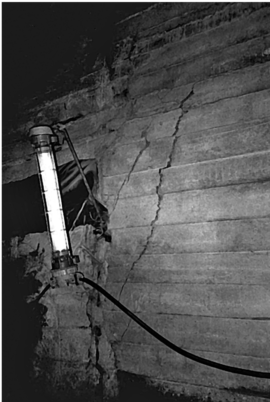
Рис. 2.10. Бетонная крепь конвейерного штрека, расположенного в соляных породах на горизонте № 6 ( H = 801 м) рудника «Интернациональный».
