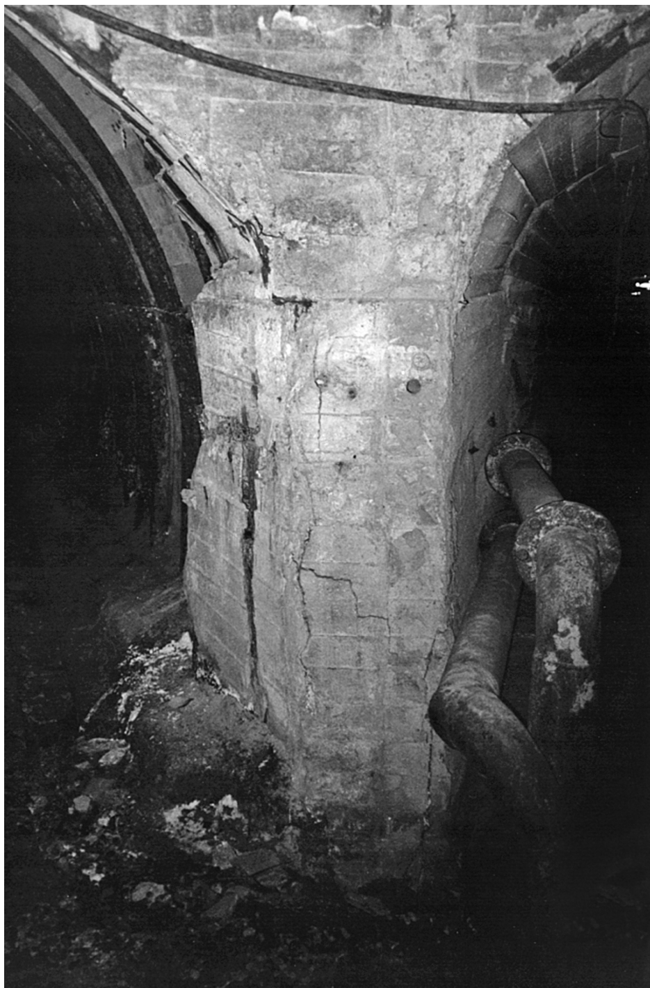
Рис. 2.12. Сопряжение горизонтальных выработок с бетонным «утюгом».
