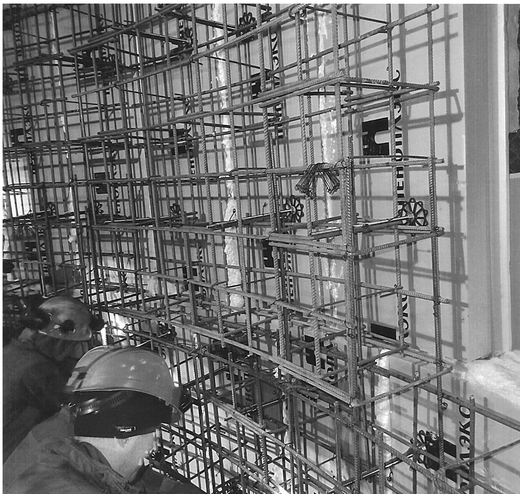
Рис. 6.45. Строительство ствола № 2 Усть-Яйвинского рудника.
