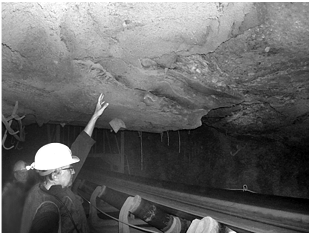
Рис. 2.2. Локальные обрушения пород кровли в пределах свода естественного равновесия с «обгрызанием» анкеров выработки сечением 20–25 м 2 .
