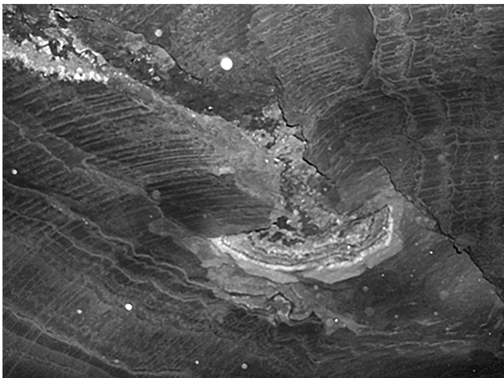
Рис. 2.1. Заколы в сводовой части кровли выработки сечением 9,0 \text{ м}^2 .
