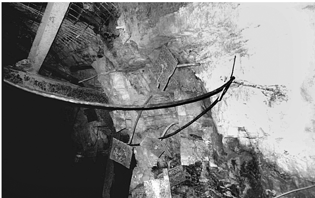
Рис. 2.21. Анкерная крепь в квершлагге горизонта № 5 рудника «Интернациональный».
