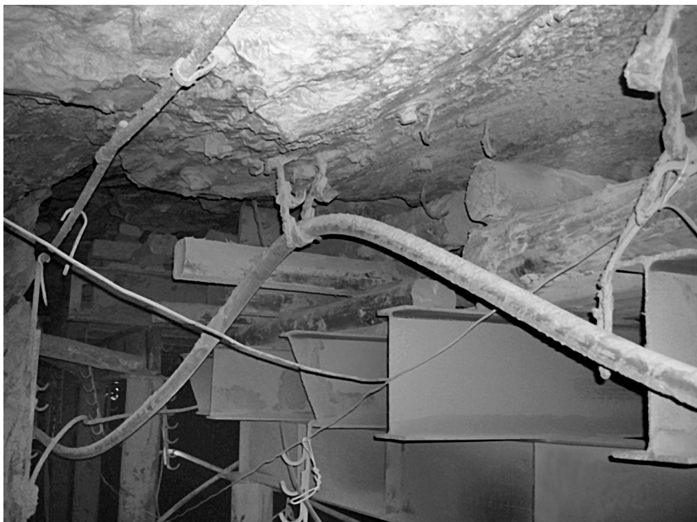
Рис. 2.3. Деформирование поперечных балок рамной крепи в выработке шириной более 8,0 м (междушахтная транспортная сбойка рудника БКПРУ-2) при заполнении пространства за рамной крепью жесткими (недеформируемыми) кострами из бруса.
