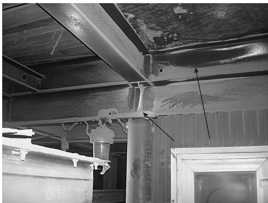
Рис. 9.7. Изгиб косынки и пластическая деформация продольной двутавровой балки (показано стрелками).
