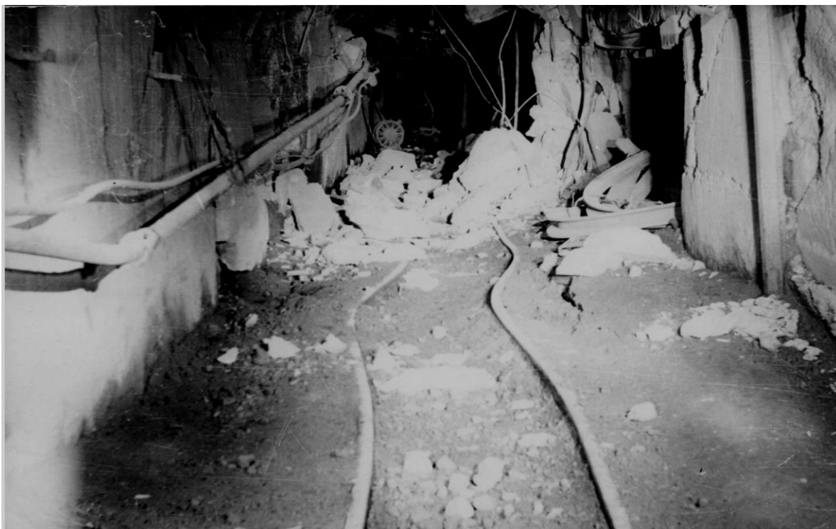
Рис. 16.9. Искривление путей в западной части орта 19.
