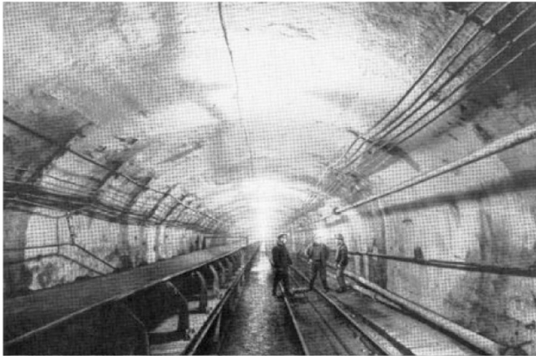
Рис. 3.5.2. Наклонный конвейерный ствол шахты «Распадская» длиной 1265 м, закрепленный железобетонной крепью
