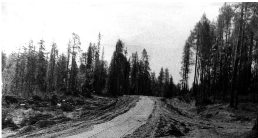
Начало строительства дороги Архангельск — Тучкино, 1984 год
