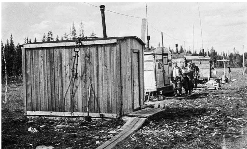
Жилые балки алмазной геологоразведки с транспортировочным такелажом для перевозки вертолетами на внешней подвеске. 1984 год
