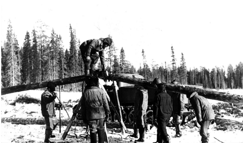
Монтаж деревянного копра (треноги) для бурения на трубке Поморская. 1981 год
