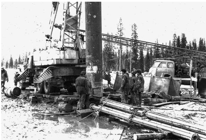
Обсадка скважины трубами диаметра 820 мм. Тучкино, 1985 год
