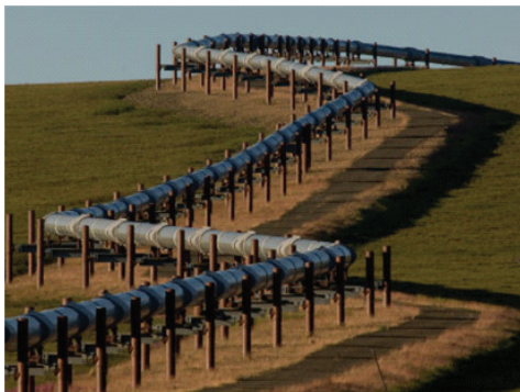
Рис. 14.2. Трубопровод на эстакаде
