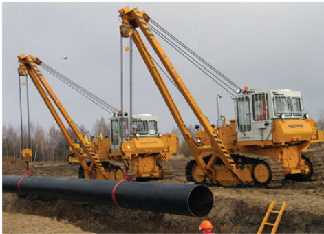
Рис. 14.1. Укладка трубопровода в траншею
