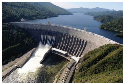
Рис. 12.1. Приплотинная ГЭС
