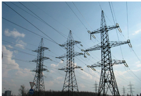
Рис. 14.4. Воздушные линии электропередач
