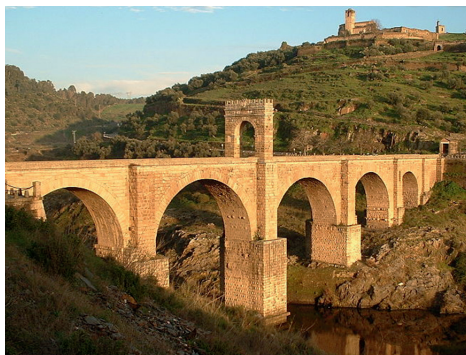
Рис. 11.1. Арочный мост Алькантара в Испании
