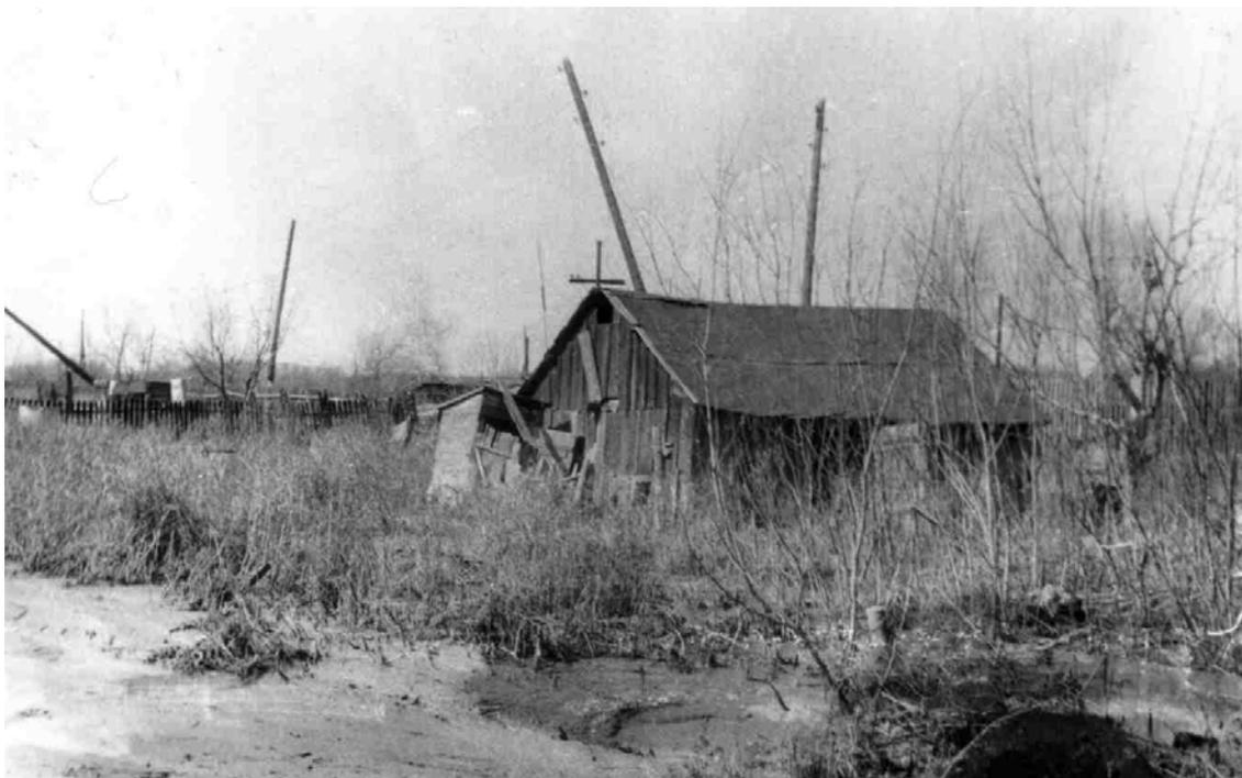
*Рис. 31. Расплывшийся язык оползня. Водонасыщенным грунтом залит двор дома по ул. Красноярской, 230*
