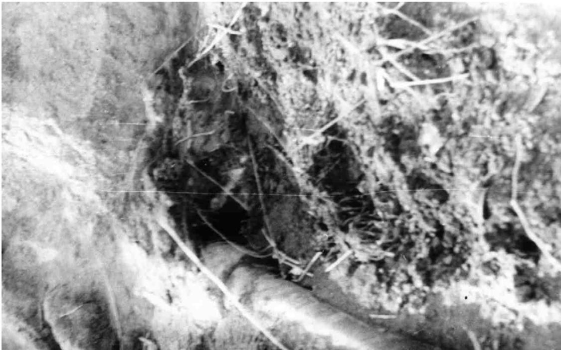
*Рис. 34. Суффозионная воронка у водовода меланжевого комбината на Обском склоне*
