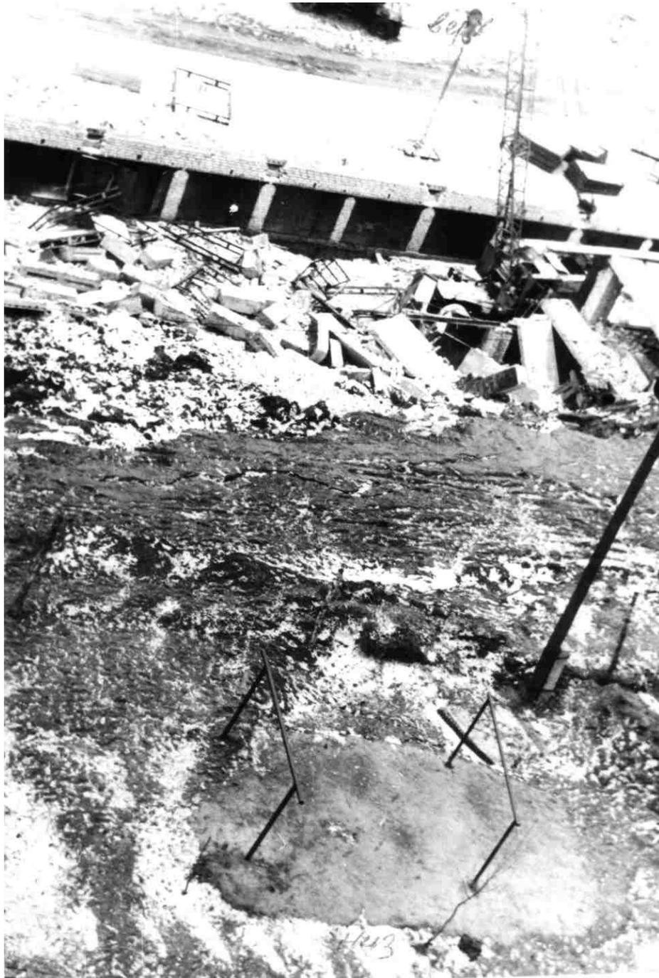
*Рис. 33. Разрушенный антропогенным оползнем 3-этажный гараж по ул. Кавалерийской, 5а. 1988 г.*
