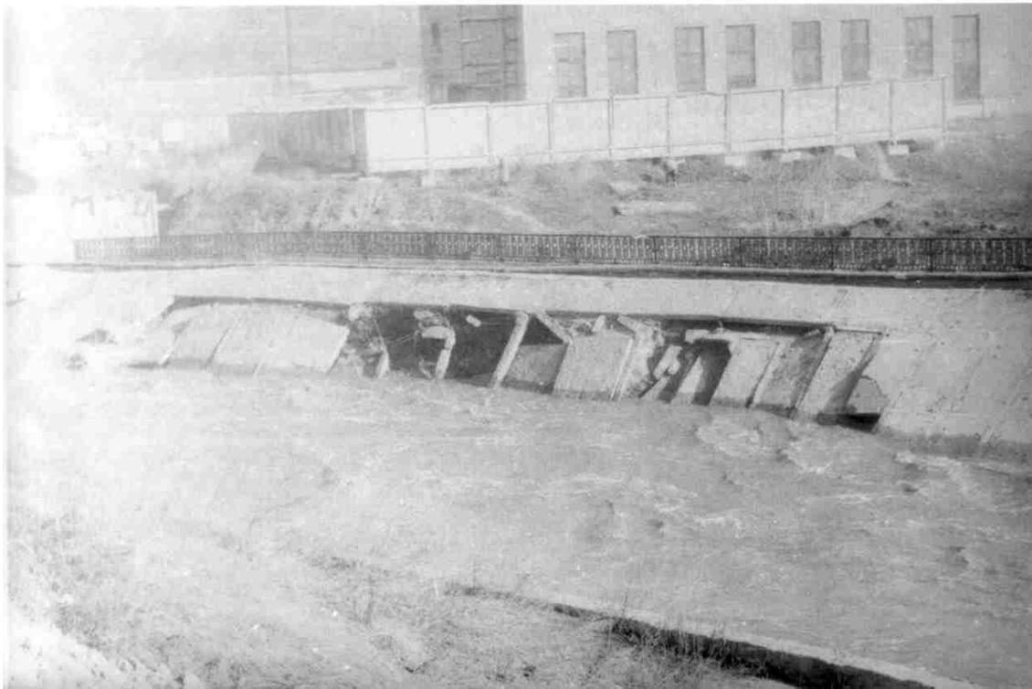
*Рис. 39. Деформация бетонных плит набережной р. Барнаулки*
