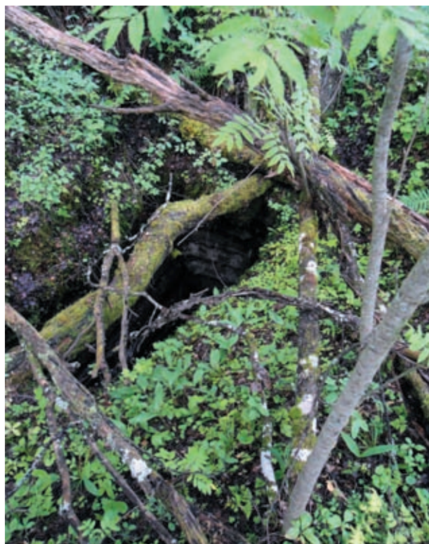
Рис. 6. Шахта «Надежда» Кончезерского медеплавильного завода (вход завален деревьями)
