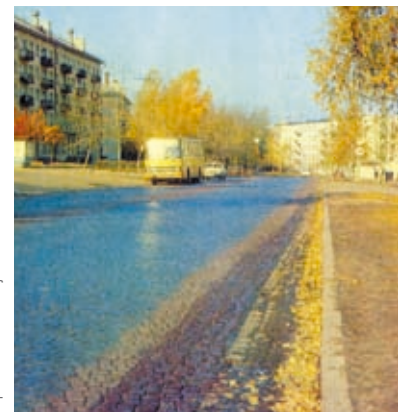
Рис. 4. Брусчатка из малинового кварцита на Первомайском проспекте г. Петрозаводска, 80-е гг.
