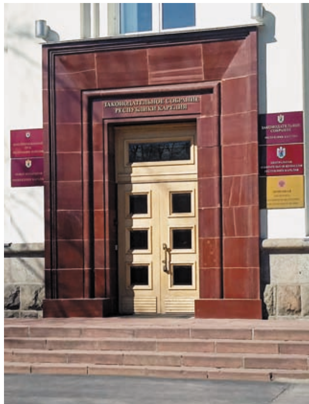
Рис. 7. Портал входа в здание Законодательного собрания Республики Карелия: полированные плиты и лестница изготовлены из малинового кварцита
