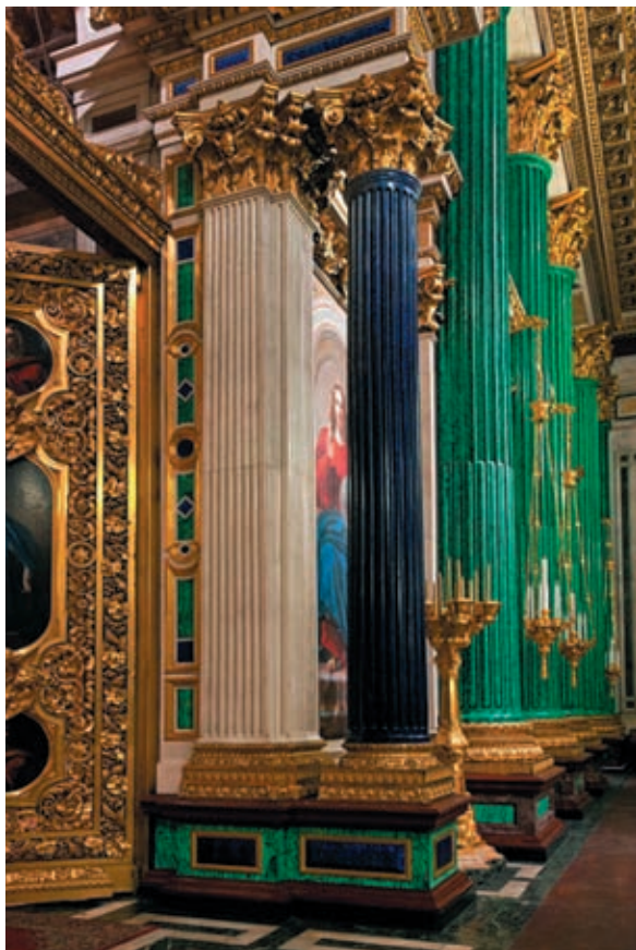
Рис. 10. Внутренний цоколь по периметру Исаакиевского собора выполнен из пород Нигозерского месторождения
