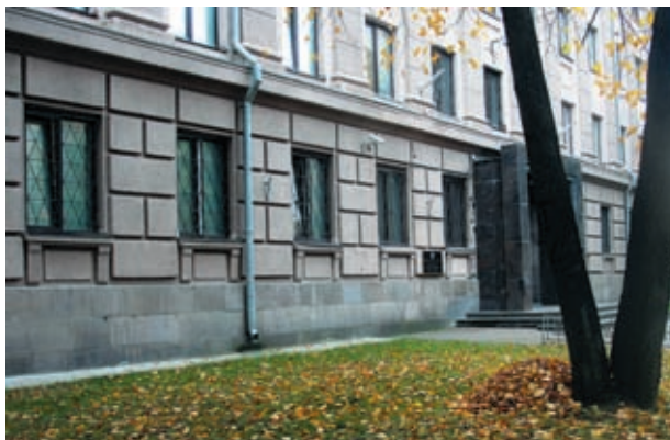
Рис. 6. Цоколь фасада здания ФСБ выполнен из каменноборского кварцитопесчаника
