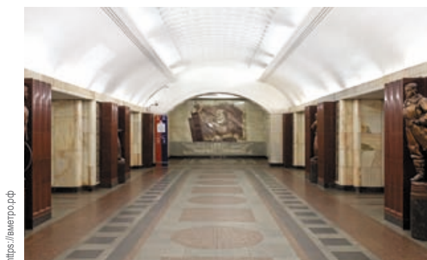
Рис. 13. Шокшинский кварцит в пилонах на станции метро «Бауманская» (г. Москва)
