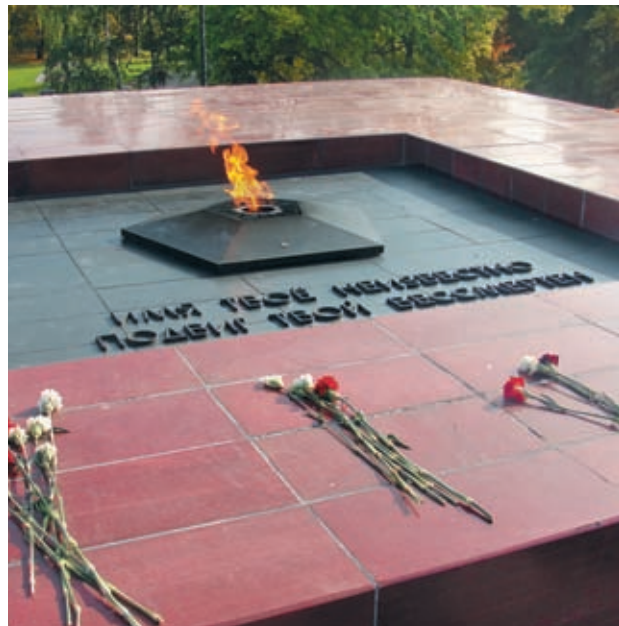
Рис. 8. Мемориальный комплекс «Могилы Неизвестного солдата с Вечным огнем славы»: площадка, окружающая Вечный огонь, выполнена из малинового кварцита
