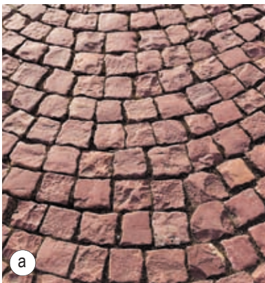
Рис. 3. Брусчатка (а) и шашка (б) из шокшинского кварцита
