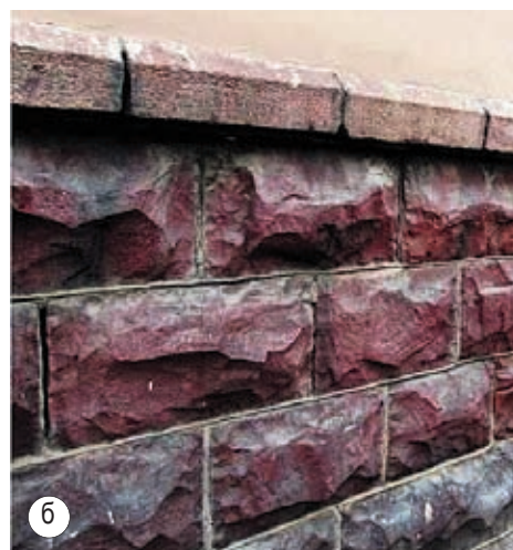
Рис. 9. Петрозаводский Государственный университет, цоколь здания (а) выполнен из шокшинского малинового кварцита (б)
