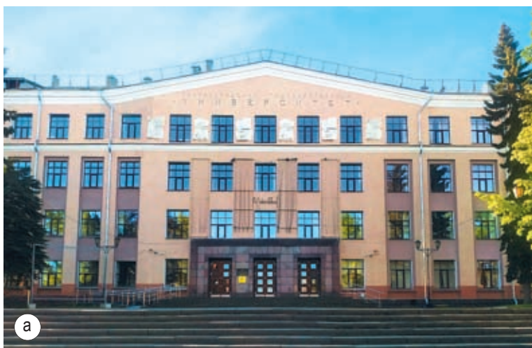
Рис. 9. Петрозаводский Государственный университет, цоколь здания (а) выполнен из шокшинского малинового кварцита (б)
