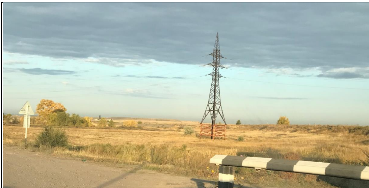
Рисунок 11 – Поднятие опоры ВЛ
