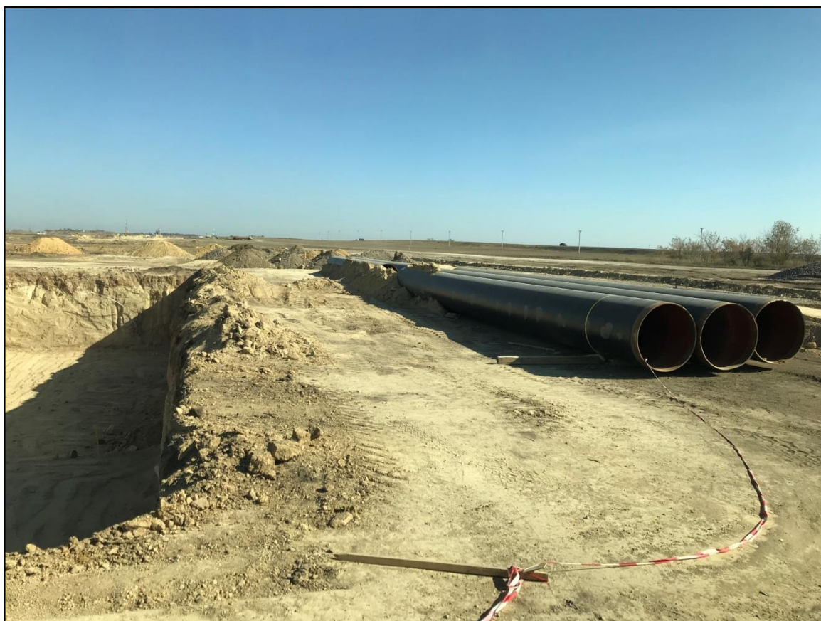
Рисунок 72 – Земляные работы по укладке стальных труб газопровода близ поселка Актас
