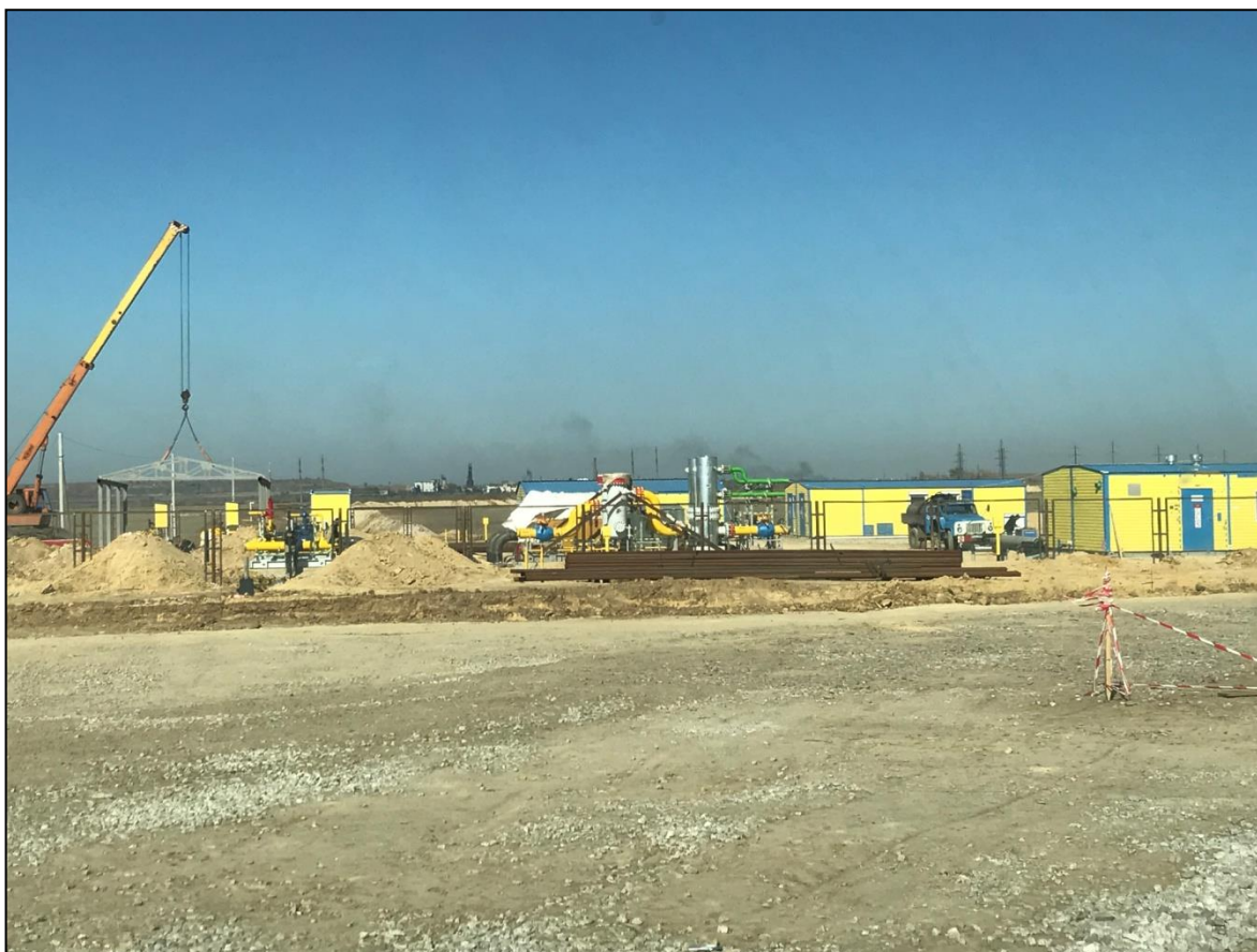
Рисунок 71 – Строительство АГРС – Караганда возле пос. Дубовка
