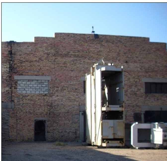
Рисунок 22 – Пункт триангуляции на здании ЦОКС
