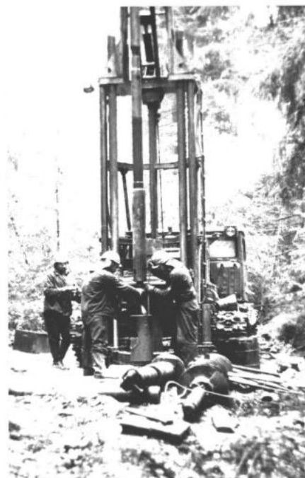
Буровая установка УБСР-25 на разведке Мансуровского месторождения песчано-гравийных материалов
