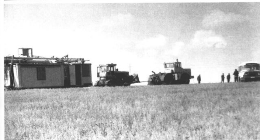
1988 г. Перевозка буровой установки на новую скважину в Южно-Воронежской ГРП
