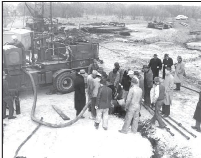
Рисунок 9 – Одна из первых операций ГРП, примерно 1949 г. (Источник: «Halliburton»)
