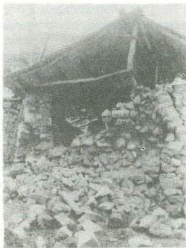
Рис. 3. Обрушение стен оутовой кладки
