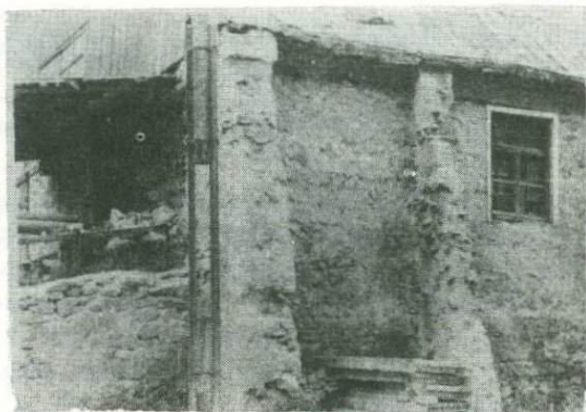
Рис. 19. Вид фасада здания с контрфорсами механического цеха при железобетонном заводе
