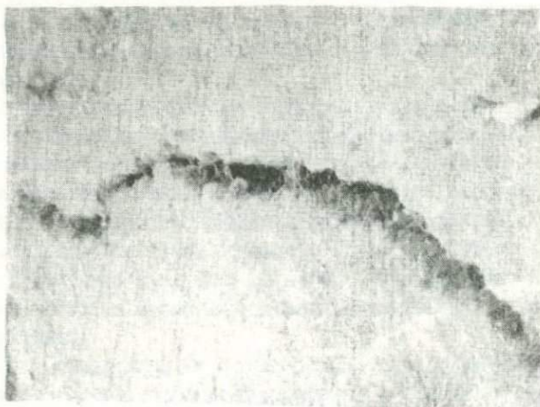
Рис. 1. Трещина, открывшаяся во время землетрясения 9 июня 1968 г.
