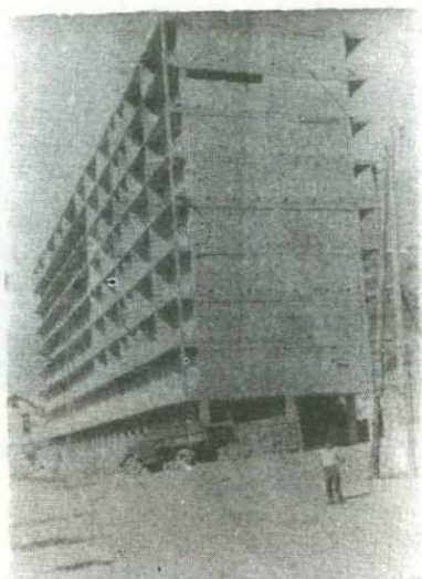
Рис. 1. Общий вид обследованного здания
