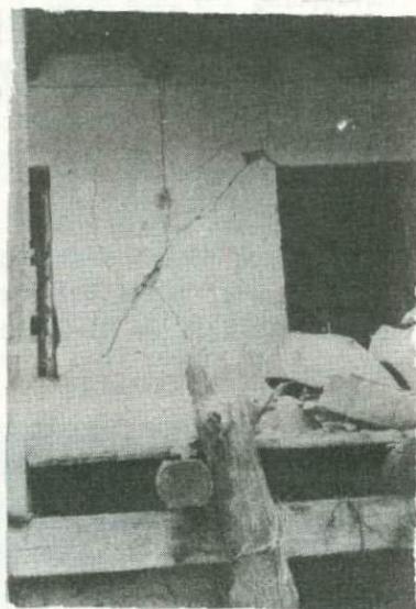
Рис. 7. Характерная X-образная трещина в простенке
