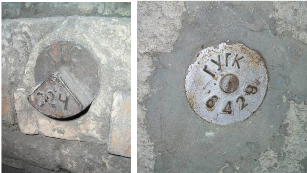
Рис. 7.27. Фото стенного репера и марки
