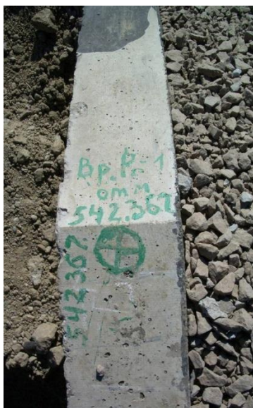
Рис. 7.24. Фото репера расположенного на шкафной стенке
