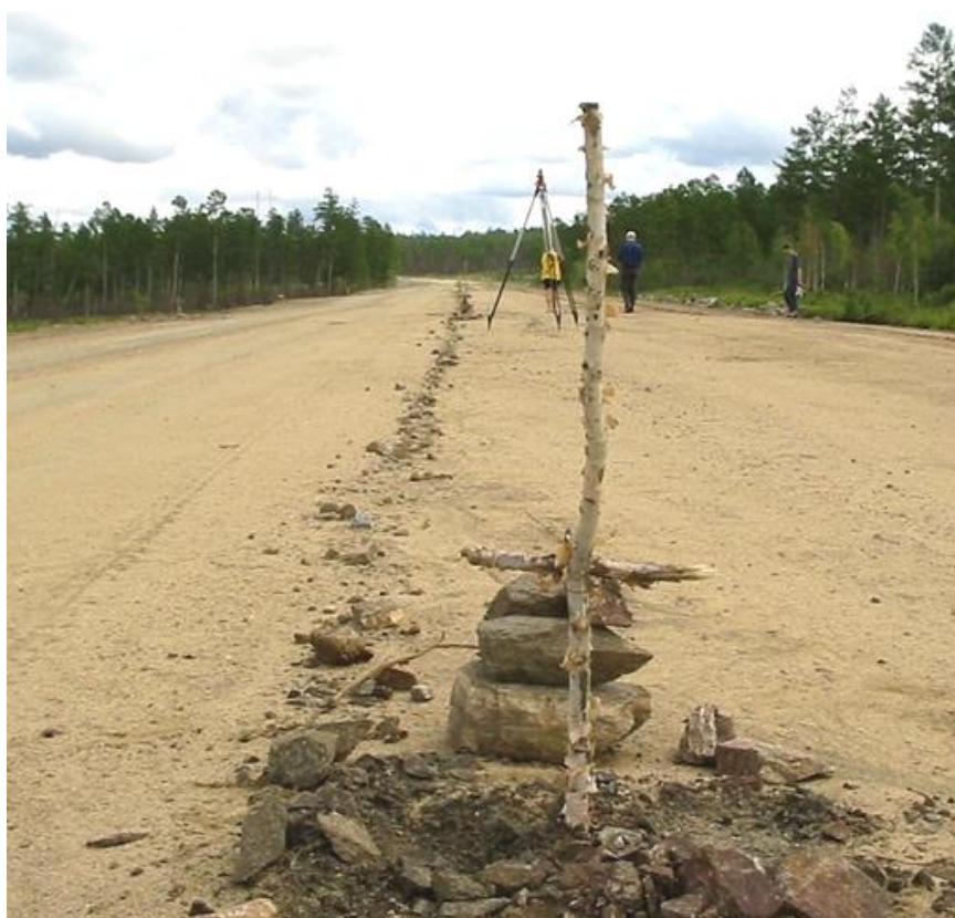
Рис. 7.30. Установленные высотные визирки для отсыпки слоя земляного полотна толщиной 0,3 м.
