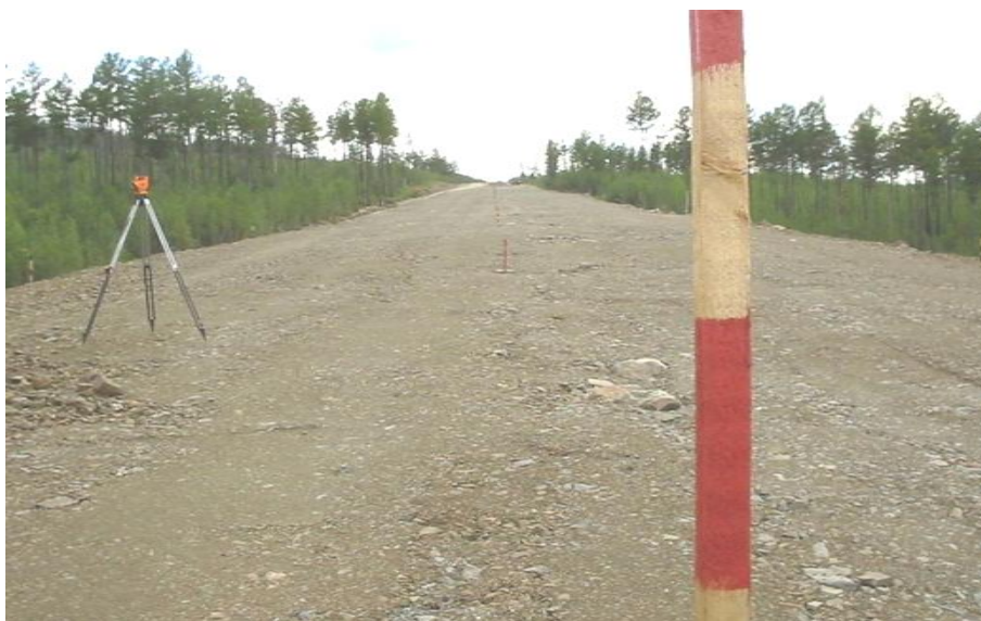
Рис. 7.28. Разбивка оси дороги и бровок земляного полотна через 50 м.
