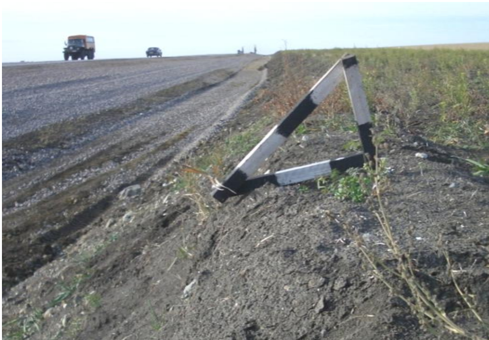
Рис. 7.32. Откосник, установленный по границе верхней бровки выемки
