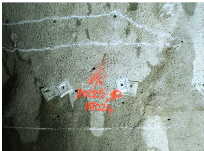
Рис. 5.41. Разметка опорных точек на стенке горной выработки
