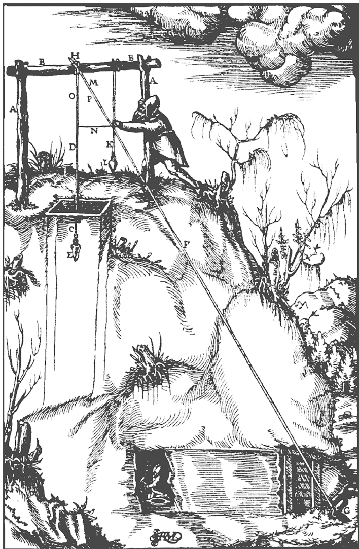
Рис. 1.5. Сбойка штольни и шахты (гравюра из книги Георга Агриколы)
