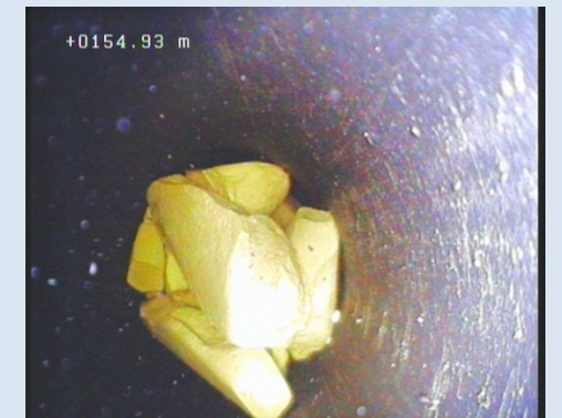
Посторонние предметы в скважине, фронтальная камера
