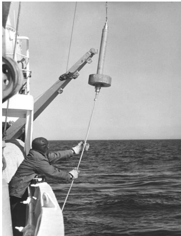
Рис.2.23. Спуск термоградиентометра на НИС «Вулканолог». 1988 г.
