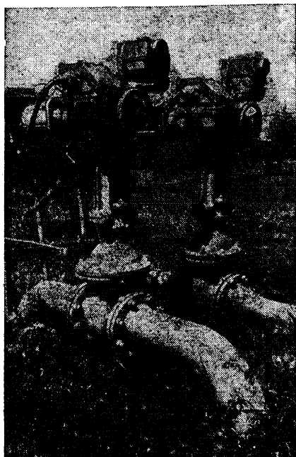
Рис. 25. Задвижки с электроприводом
